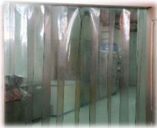
ภาพแสดงการติดตั้งม่านพลาสติกบริเวณทางเข้าออก เพื่อป้องกันไม่ให้สัตว์พาหะเข้าพื้นที่ปรุงอาหาร
